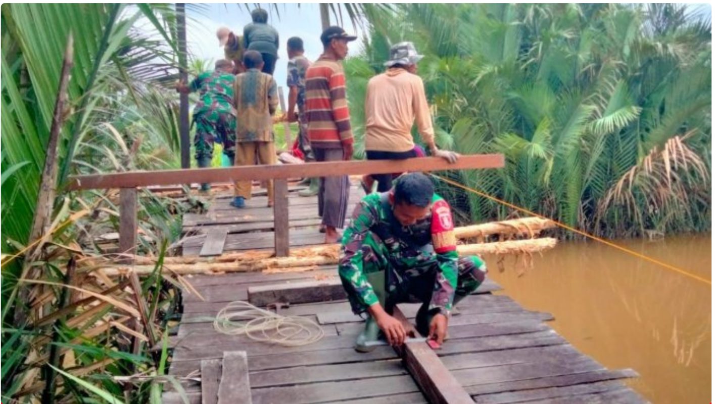
Babinsa Koramil 1005-11/Tabunganen Bersama Warga Gotong Royong Perbaiki Jembatan Yang Rusak
